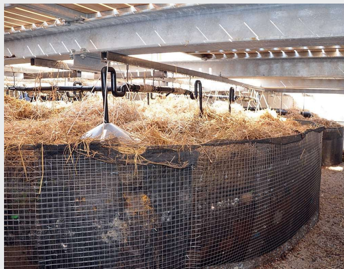
Fig. 1 À gauche: terrasse en bois qui couvre la fosse de traitement. À droite: lombrifiltre des eaux noires au moment de l'inauguration. (Photo de gauche par Annik Wetter, photo de droite par Equilibre)
