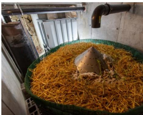
En automne 2024, l'installation de traitement des eaux grises du bâtiment de la Coopérative d'habitation Equilibre à Cressy a été mise à jour pour améliorer la qualité de l'eau traitée en sortie de l'installation grâce à l'ajout d'une étape de traitement par lombrifiltration en tête de filtre planté.
